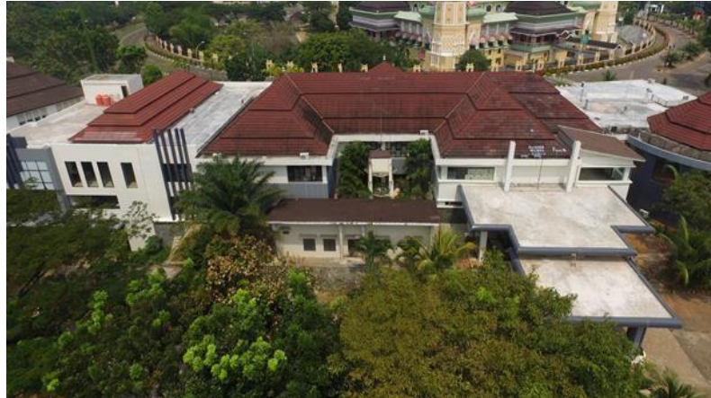
Gambar 1.1 Gedung Dinas Perumahan Rakyat dan Kawasan Permukiman Provinsi Banten
