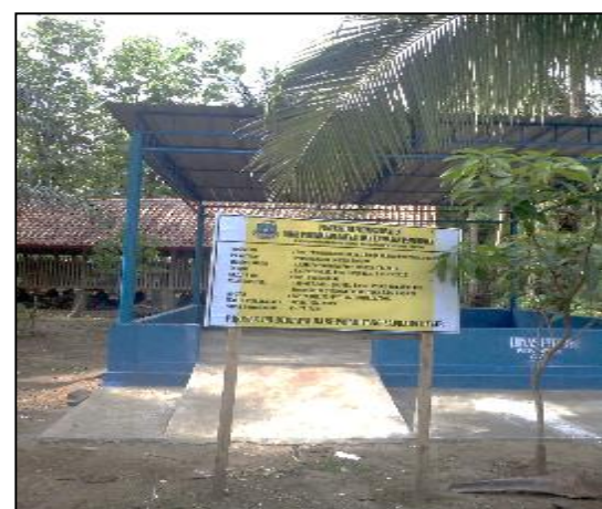
Kondisi Sesudah Dikerjakan (100%)
