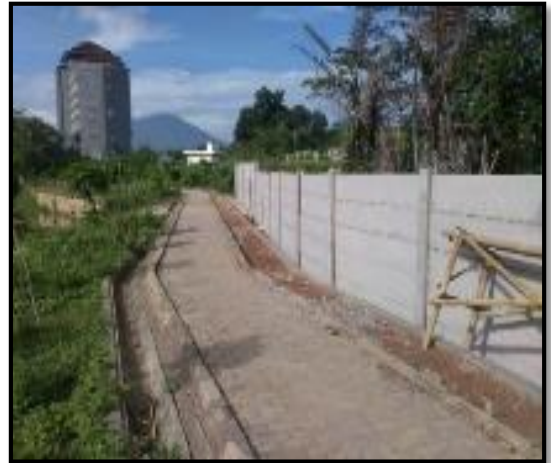
Kondisi Sesudah Dikerjakan (100%)
