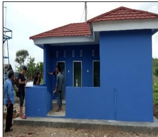
Kondisi Sesudah Dikerjakan (100%)
