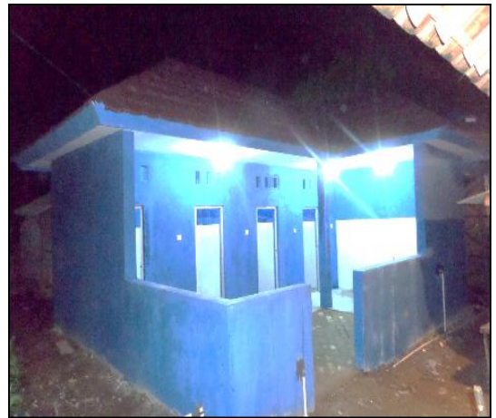
Kondisi Sesudah Dikerjakan (100%)
