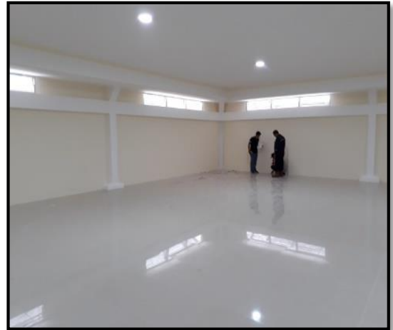
Kondisi Sesudah Dikerjakan (100%)
