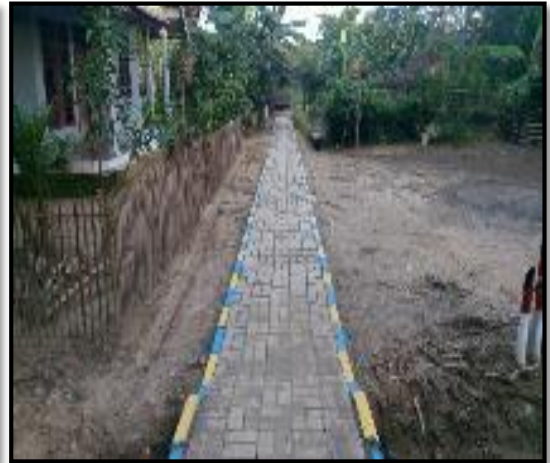
Kondisi Sesudah Dikerjakan (100%)
