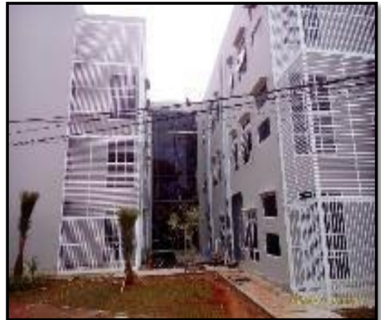
Kondisi Sesudah Dikerjakan (100%)
