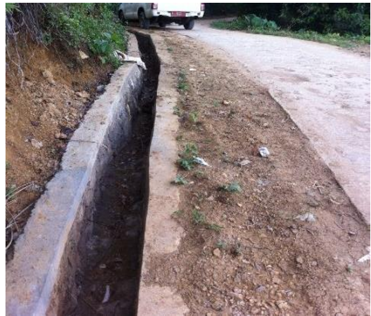
Kondisi Sesudah Dikerjakan (100%)
