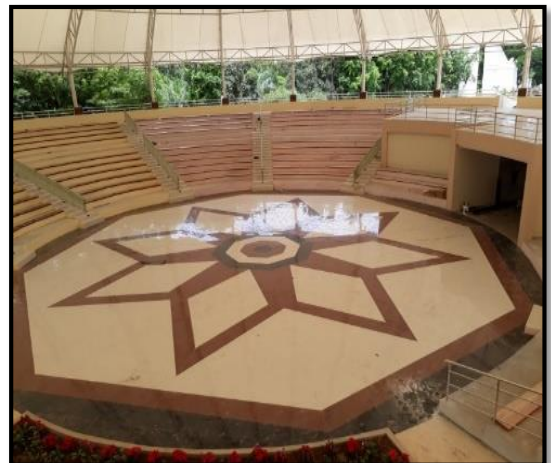
Kondisi Sesudah Dikerjakan (100%)
