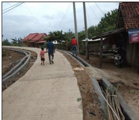
Kondisi Sesudah Dikerjakan (100%)
