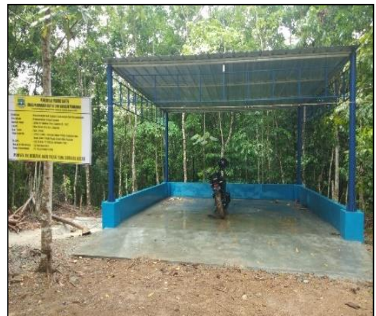
Kondisi Sesudah Dikerjakan (100%)
