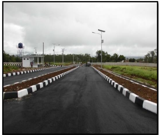
Kondisi Sesudah Dikerjakan (100%)
