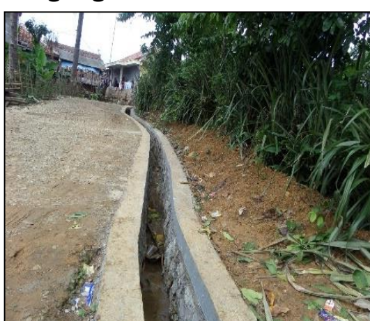
Kondisi Sesudah Dikerjakan (100%)
