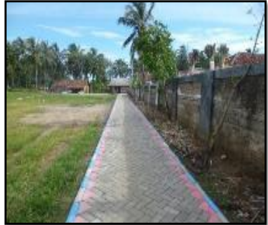
Kondisi Sesudah Dikerjakan (100%)
