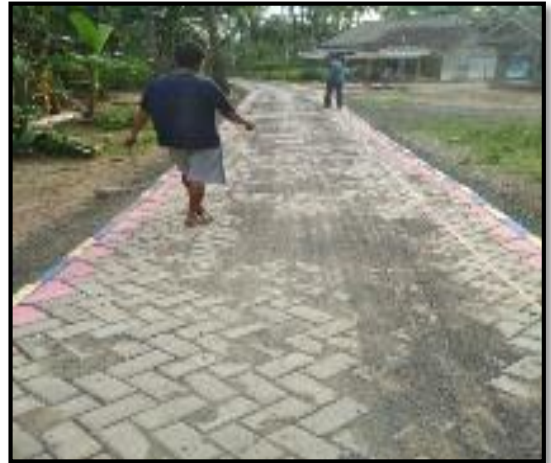
Kondisi Sesudah Dikerjakan (100%)
