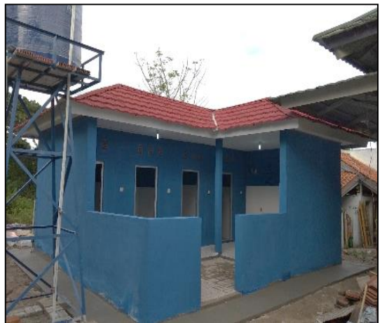
Kondisi Sesudah Dikerjakan (100%)
