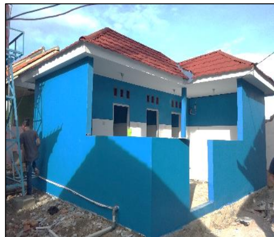
Kondisi Sesudah Dikerjakan (100%)
