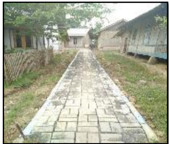
Kondisi Sesudah Dikerjakan (100%)
