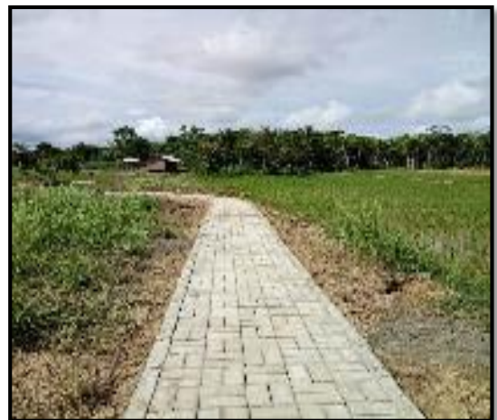
Kondisi Sesudah Dikerjakan (100%)
