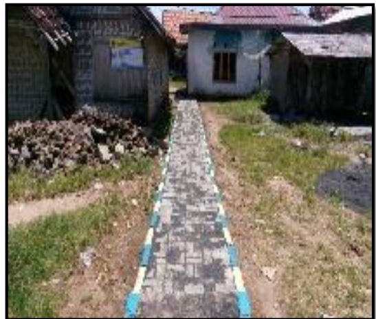
Kondisi Sesudah Dikerjakan (100%)
