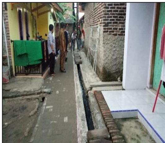
Kondisi Sesudah Dikerjakan (100%)
