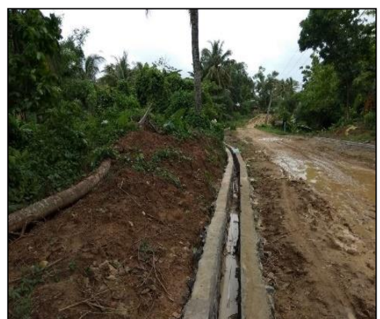
Gambar 3.17 Pembangunan Drainase Kp. Bojong Datar Desa Tanjungan Kec. Cikeusik Kab. Pandeglang
