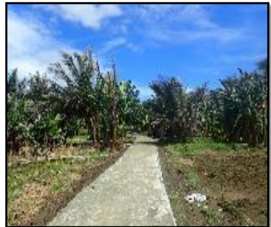
Kondisi Sesudah Dikerjakan (100%)
