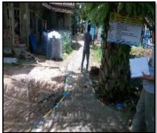
Kondisi Sesudah Dikerjakan (100%)
