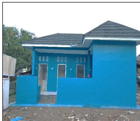
Kondisi Sesudah Dikerjakan (100%)
