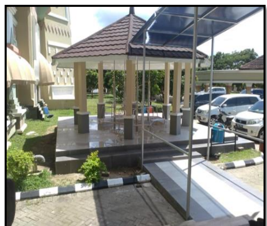
Kondisi Sesudah Dikerjakan (100%)
