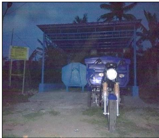
Kondisi Sesudah Dikerjakan (100%)
