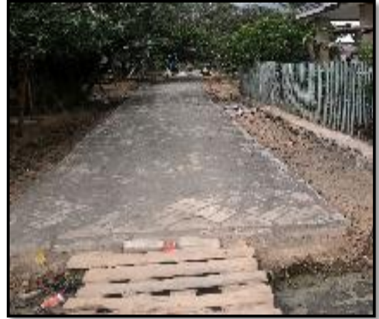
Kondisi Sesudah Dikerjakan (100%)
