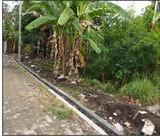
Kondisi Sesudah Dikerjakan (100%)
