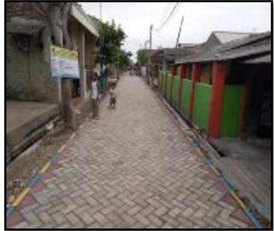
Kondisi Sesudah Dikerjakan (100%)
