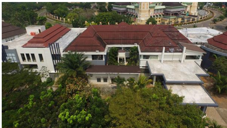
Gambar 1.1 Gedung Dinas Perumahan Rakyat dan Kawasan Permukiman Provinsi Banten
