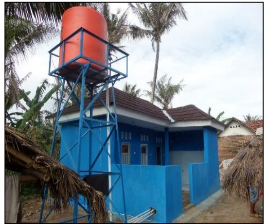
Kondisi Sesudah Dikerjakan (100%)
