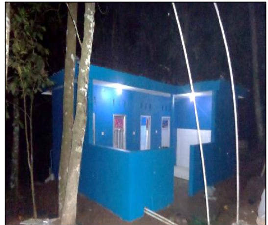
Kondisi Sesudah Dikerjakan (100%)
