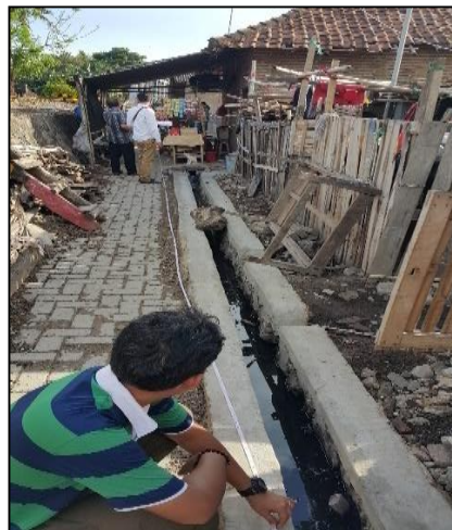
Kondisi Sesudah Dikerjakan (100%)
