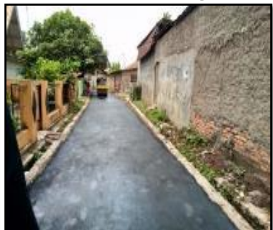
Kondisi Sesudah Dikerjakan (100%)
