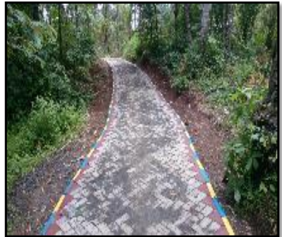
Kondisi Sesudah Dikerjakan (100%)
