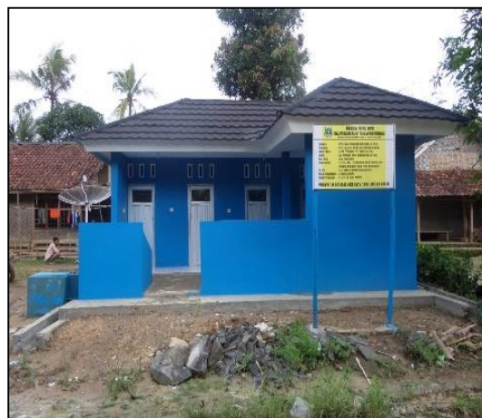
Kondisi Sesudah Dikerjakan (100%)
