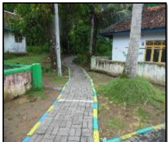
Kondisi Sesudah Dikerjakan (100%)
