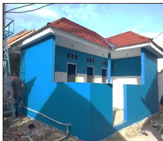
Kondisi Sesudah Dikerjakan (100%)
