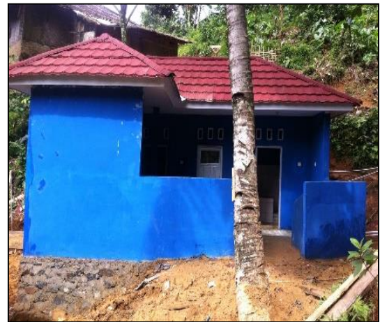
Kondisi Sesudah Dikerjakan (100%)
