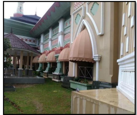
Kondisi Sesudah Dikerjakan (100%)
