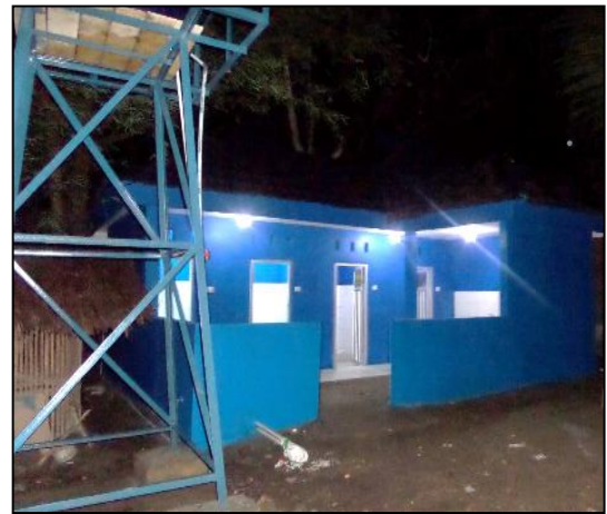
Kondisi Sesudah Dikerjakan (100%)
