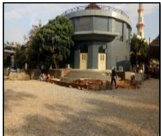
Kondisi Sesudah Dikerjakan (100%)
