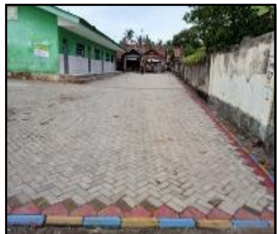
Kondisi Sesudah Dikerjakan (100%)
