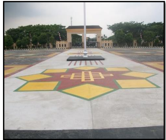
Kondisi Sesudah Dikerjakan (100%)
