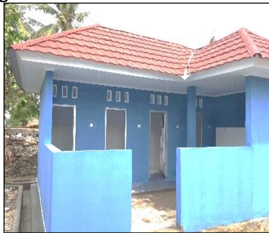
Kondisi Sesudah Dikerjakan (100%)
