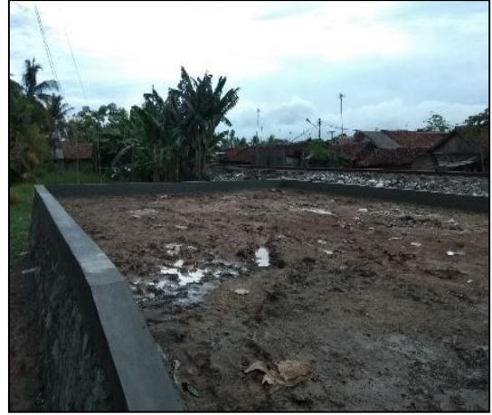
Kondisi Sesudah Dikerjakan (100%)
