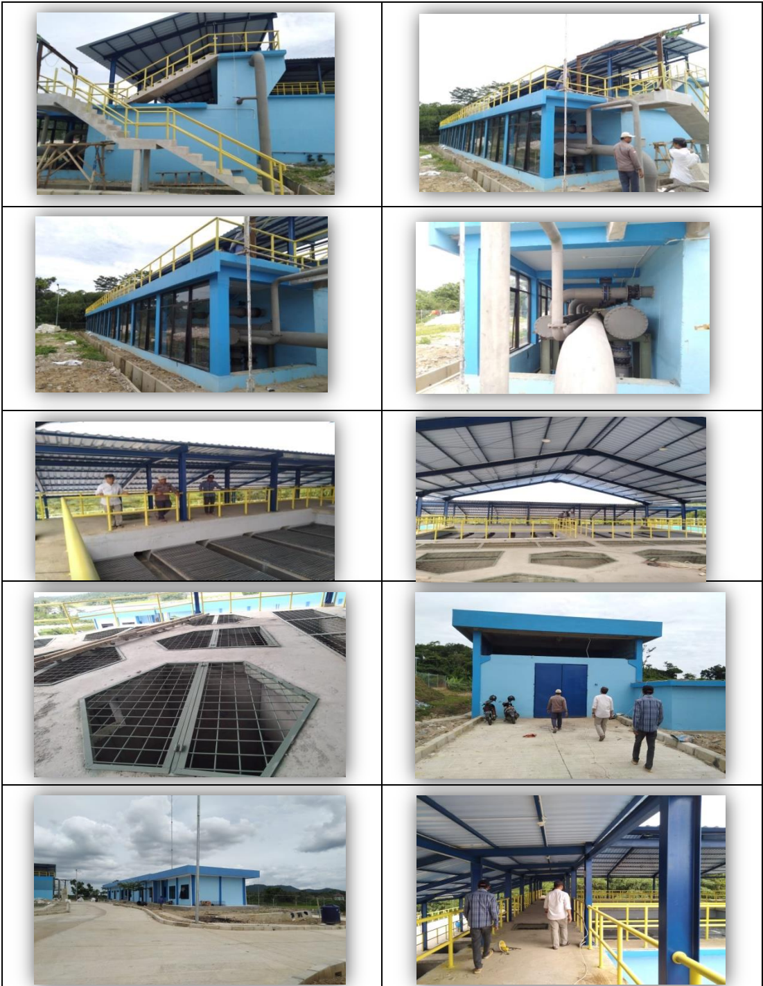
PEMBANGUNAN WTP SINDANG HEULA
